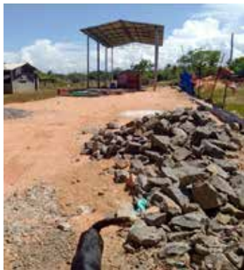
W tle nieukończony kościół
